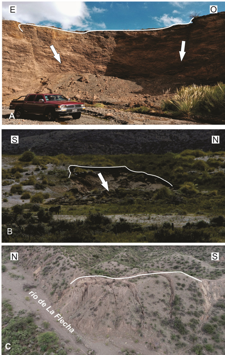
FIG. 4. Deslizamientos de suelos y rocas. A. Deslizamiento de roca en el área del barreal Barrancas. B. Deslizamiento de una vega en el puesto de los Papagallos. C. Deslizamiento rotacional en el margen sur de la quebrada del río de La Flecha (imagen obtenida con un vehículo aéreo no tripulado).
