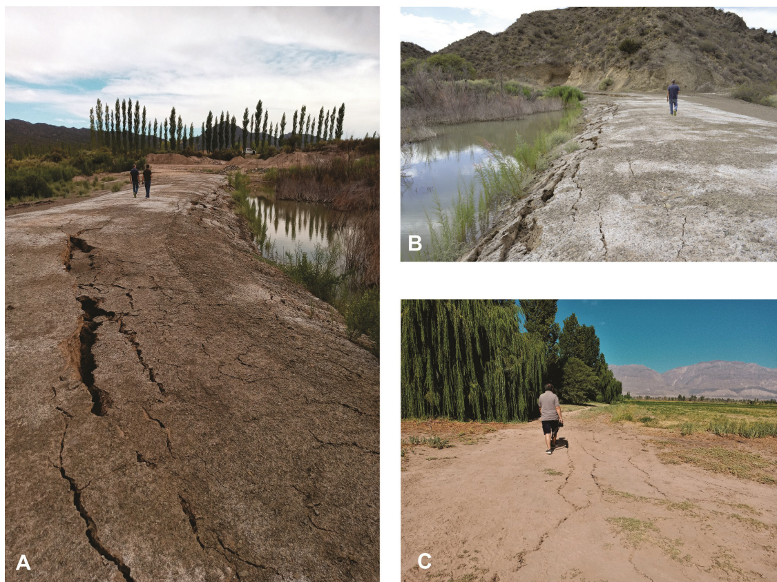
FIG. 6. Desplazamientos laterales. A-B , Estancia La Ciénaga. C , Establecimiento agrícola en Carpintería.
