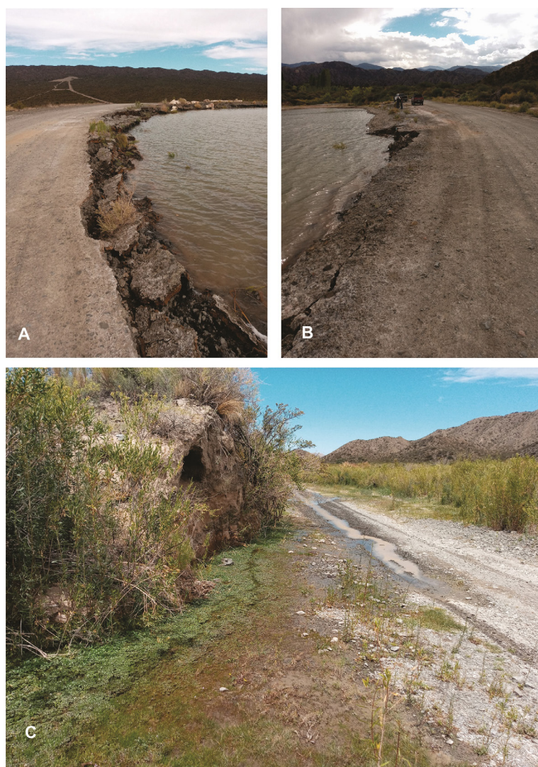
FIG. 10. Daños producidos por el oleaje en la represa artificial de la estancia La Ciénaga. A. Margen noreste. B. Margen suroeste. C. Aumento de caudal registrado a la mañana siguiente del evento sísmico en una vertiente ubicada en el puesto de los Papagallos, la que inundó parcialmente la huella de acceso.
